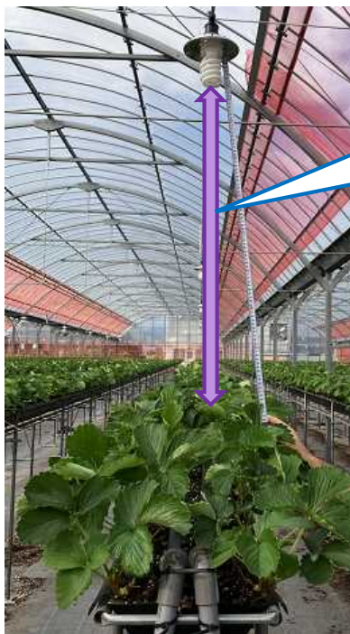
蛍光灯の設置
