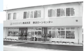
静岡支店・静岡ローンセンター移転新築
